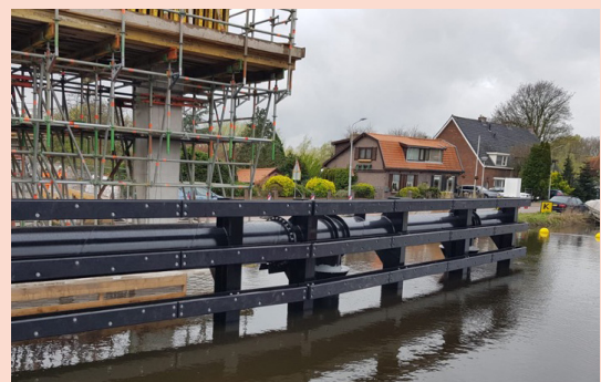
De aangebrachte geleidewerken
