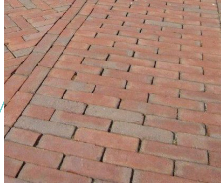
Gebakken klinkers in het trottoir
