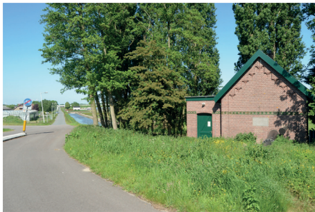
Gemaal Osdorper Bovenpolder.
