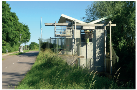
Gemaal van de Osdorper Binnenpolder.
