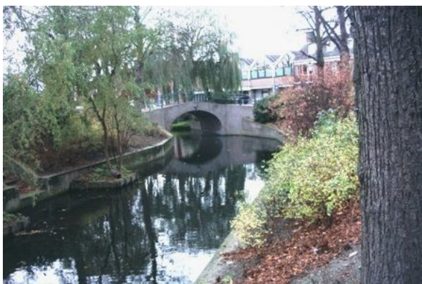
Afbeelding 1; Brug over Rijnsburgervliet, te Rijnsburg
