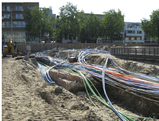
Afbeelding 1; voorbeeld van de aanleg van kabels
