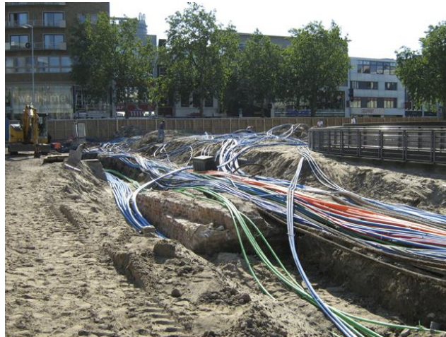
Afbeelding 1; voorbeeld van de aanleg van kabels
