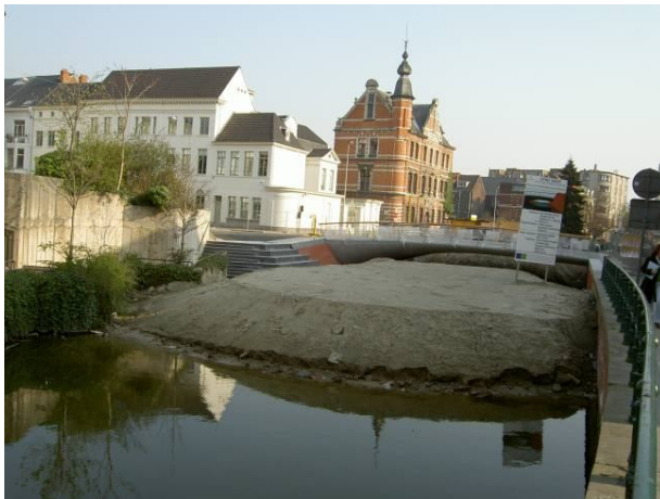
Afbeelding 1; demping van een oppervlaktewater
