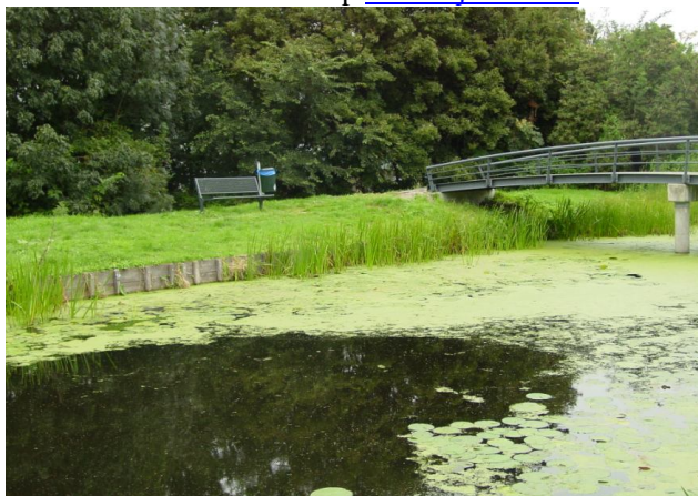
Afbeelding 1; Voorbeeld van een beschoeiing
