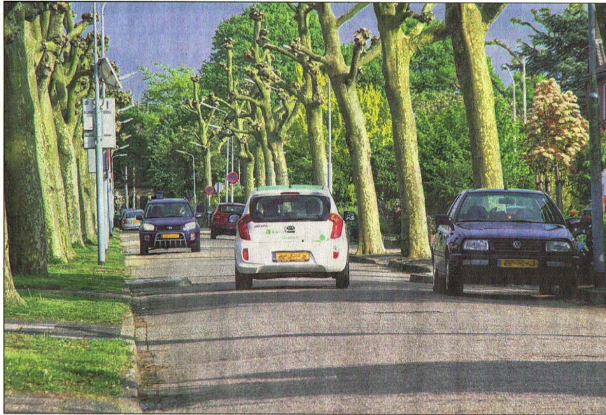
Op de Eugenie Previnairweg zijn kort geleden enkele chicanes vervangen door drempels.
