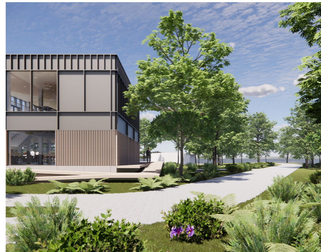
9 - zicht langs voetpad richting uitzichtpunt
