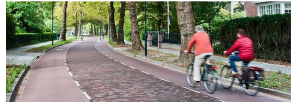
straatprofiel (gecombineerde autoweg en fietspaden)
