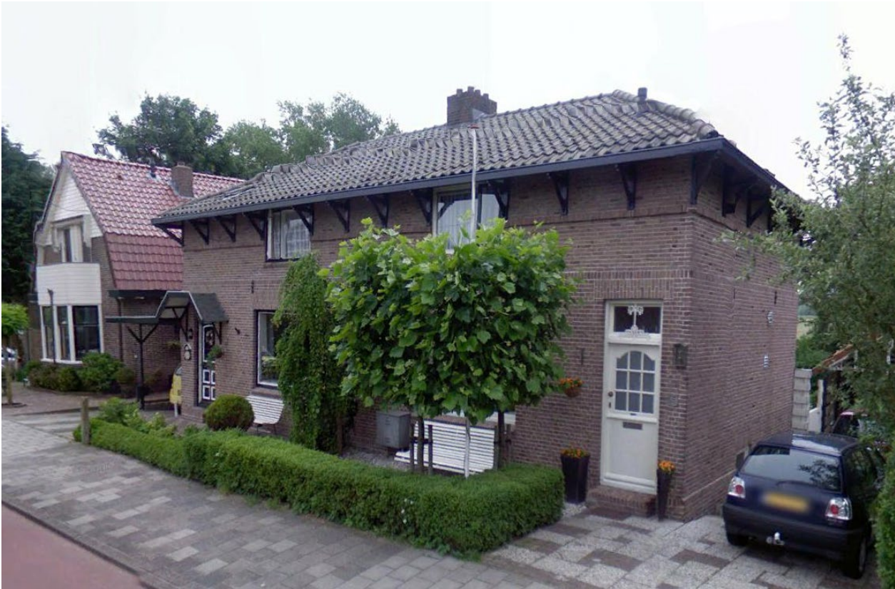
Figuur 5 Nieuwemeerdijk 229 t/m 231 die binnen een straal van 45 m vanaf de damwanden liggen.
