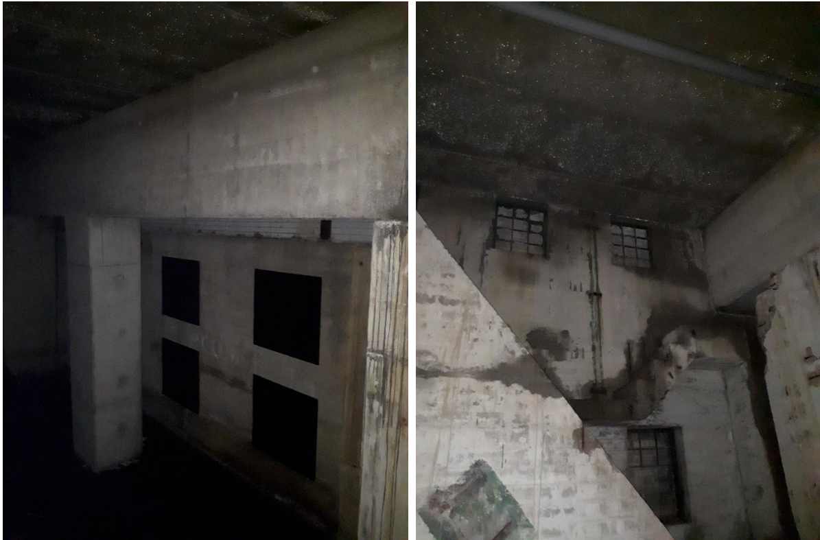
Figuur 5.5. Basculekelder van de binnenzijde.
