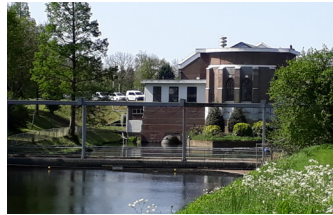
Zicht op het gemaal Leeghwater
