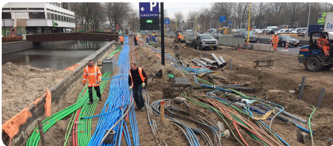
Ondergrondse infrastructuur De Boelelaan
