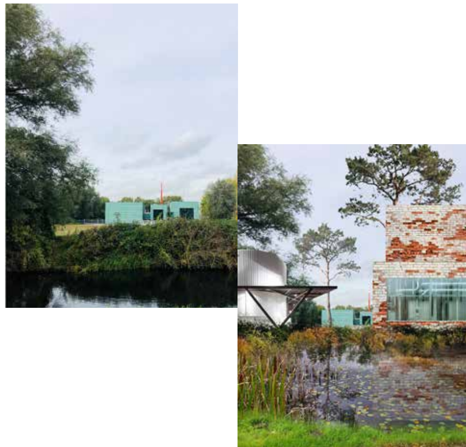
Onderstation aan de Anderlechtlaan, Gemeente Amsterdam, 2020
